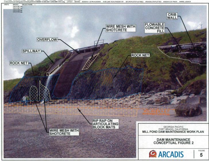
SPILLWAY OVERFLOW WIRE MESH WITH SHOTCRETE ROCK NET **ROCK NET** GEORGIA PACIFIC FORT BRAGG, CALIFORNIA MILL POND DAM MAINTENANCE WORK PLAN RIP RAP ON ARTICULATING BLOCK MATS DAM MAINTENANCE CONCEPTUAL FIGURE 3 **ARCADIS** FIGURE NOTE: RIP RAP NOT SHOWN FOR CLARITY 6
